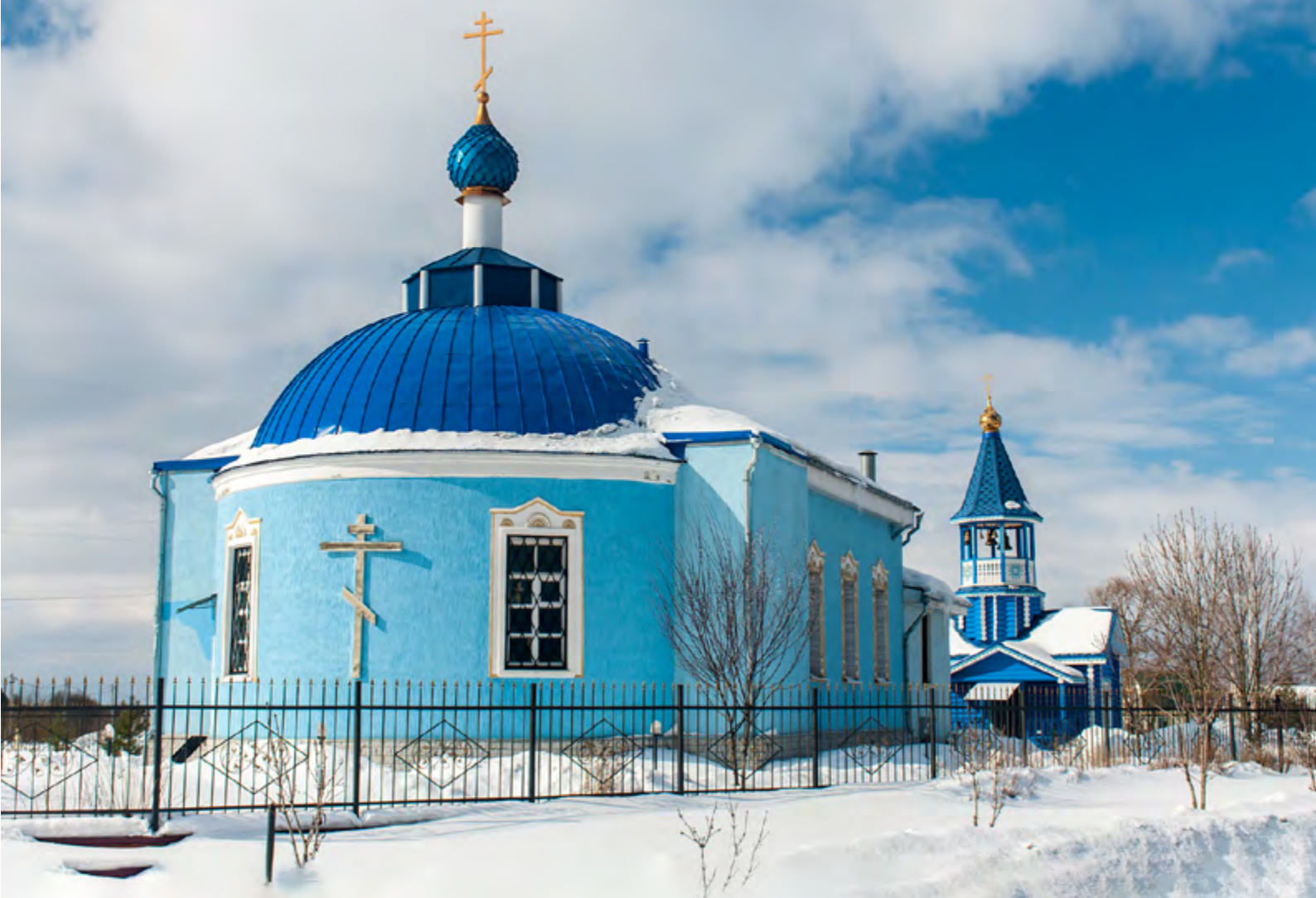
Введенская церковь в Чанках. Современный вид
